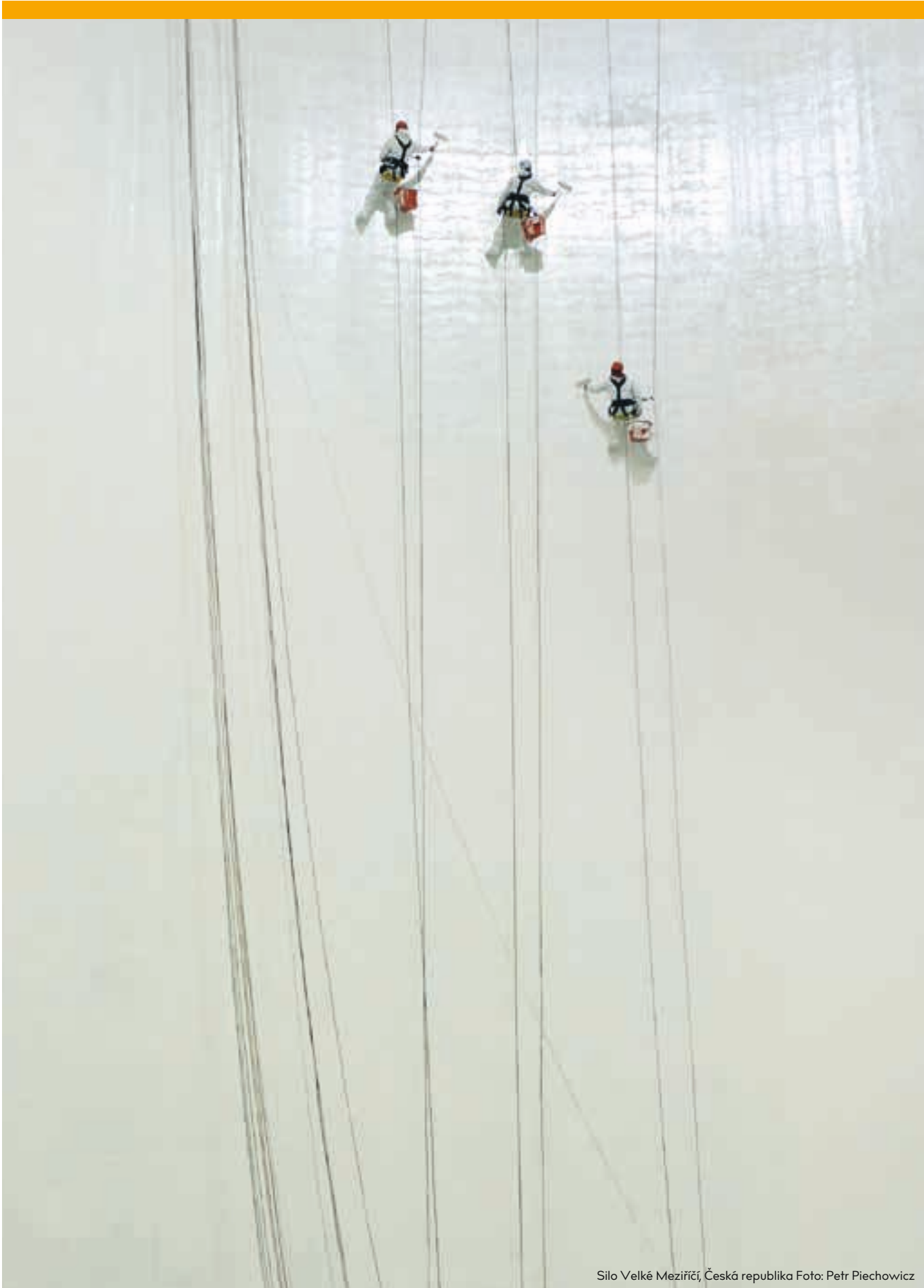
Silo Velké Meziříčí, Česká republika Foto: Petr Piechowicz
